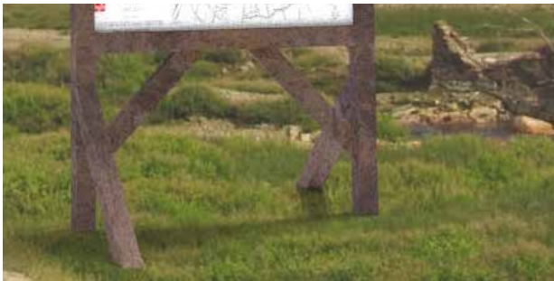
2 renforts: 1 à l'avant, 1 à l'arrière
