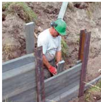
Montage des planches
